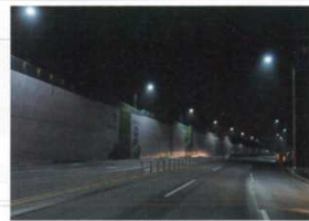
LED街路灯設置
