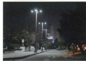
LED防犯灯設置
